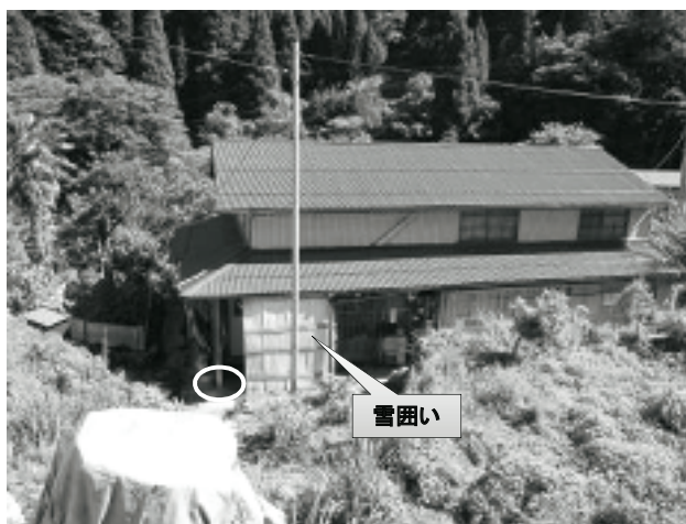
図 2-8-7. 現地の写真（○で囲った部分が事故の発生現場）
